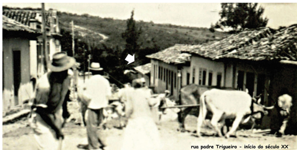
Figura 1 – Vista Parcial do Colégio Padre Trigueiro.
