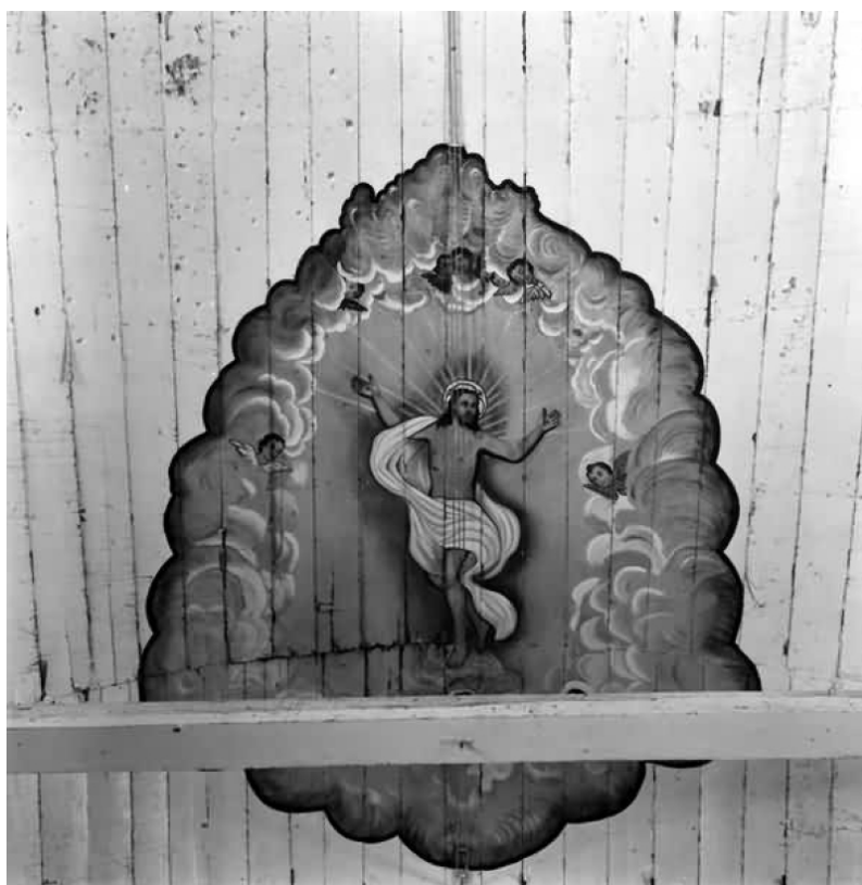
Figura 18 – Desgaste do forro
